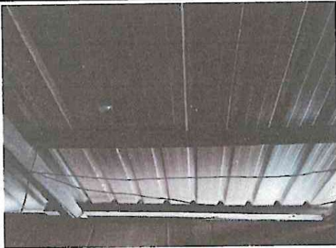
Foto1: sustitución de lamona, por lamina troquelada
