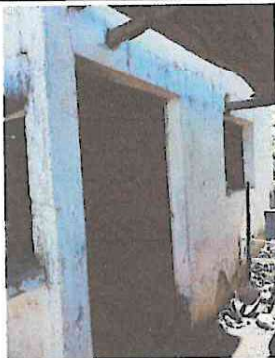
Foto 3: Reparacion de muro perimetral de block
