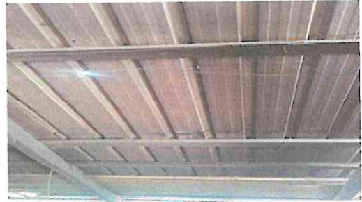
Foto 2: Sustitución de estructura de soporte(madera) por metal
